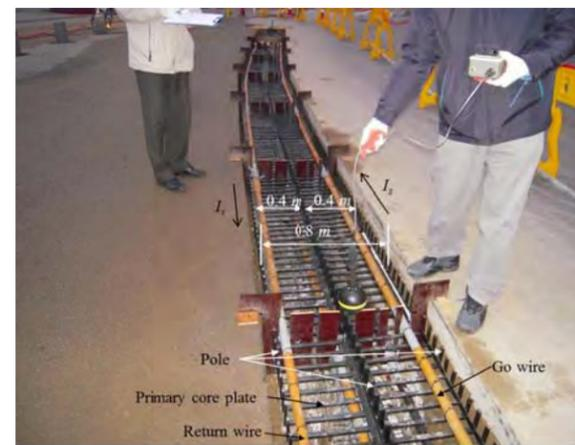
Figure 17 : Construction d' une voie OLEV
