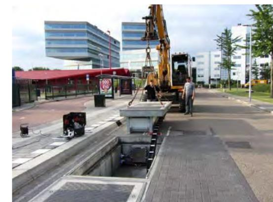
Figure 14 : Mise en place de l'infrastructure de recharge par induction IPT™ à Den Bosch
